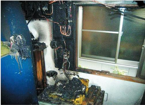
写真3-1 作業場内の分電盤付近の状況
