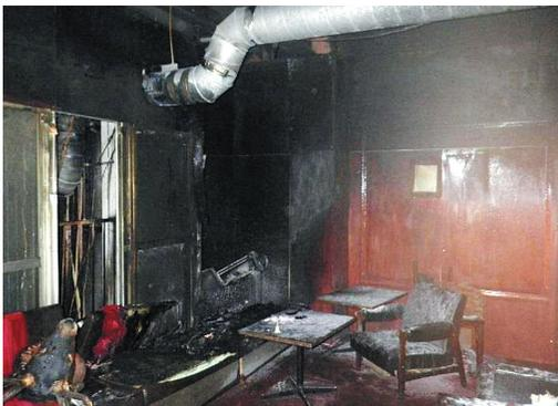
写真1-2 延焼拡大した8階の焼損状況
