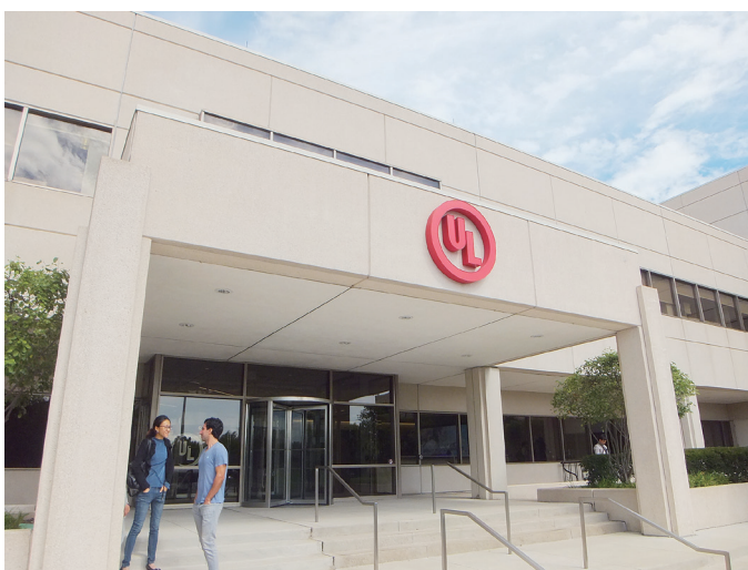
写真-1 UL外観
