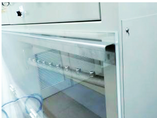
写真-11 保護カバー（新設）
