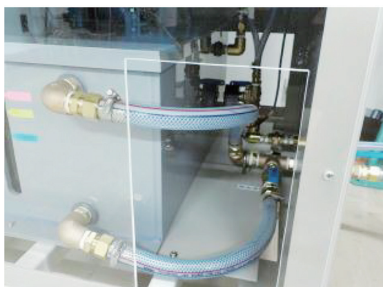
写真-8 給水及び排水設備（新設）
