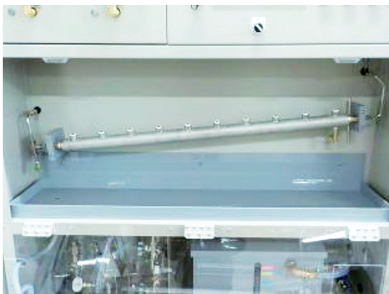
写真-6 ヘッド取付部（新設）
