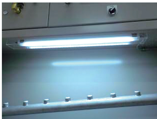
写真-7 ヘッド取付部上部照明（新設）
