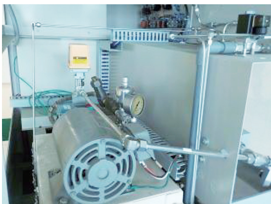
写真-3 ポンプ部分（既設）
