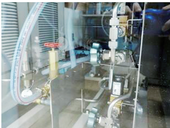
写真-9 圧力調整バルブ（新設）
