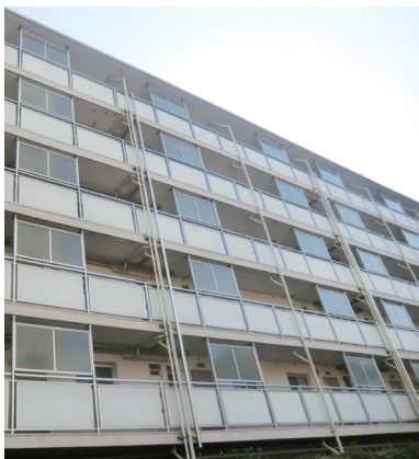
図3-7 外気に開放された廊下と防風スクリーン（戸山ハイツ）
