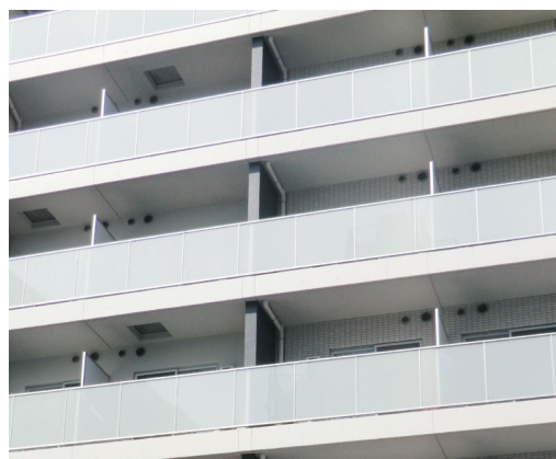
図3-4 連続バルコニーと容易に破壊できる仕切板（戸山ハイツ）
