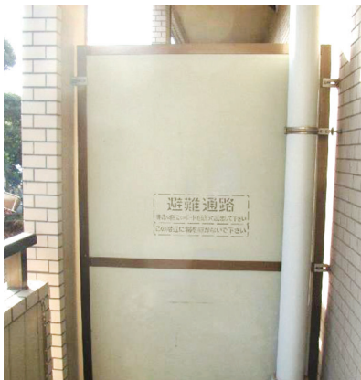
図3-5 容易に破壊できる仕切り板
