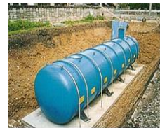
【耐震性貯水槽】
