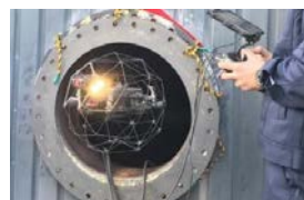
【デジタル技術を活用した効果的な予防保全の例 (ドローンを用いたタンク内部の点検)】
