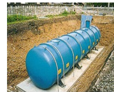
【耐震性貯水槽】
