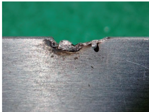
写真2-2 コンセントカバーの焼損状況
