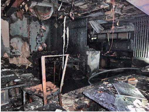
写真1-1 焼損した店内の状況
