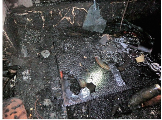
写真1-2 焼損した客席状況
