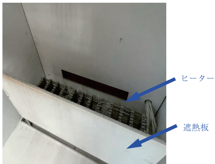
写真4 熱気流発生部
