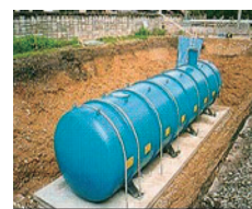
【耐震性貯水槽】
