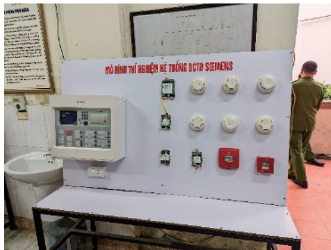
自動火災報知設備サンプルの展示
