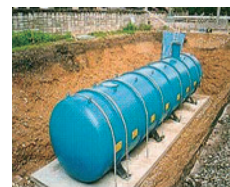
【耐震性貯水槽】
