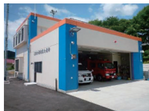
【消防庁舎復旧事業】 大船渡地区消防組合大船渡消防署 三陸分署綾里分遣所
