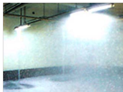
図 フォームヘッドによる泡放射
