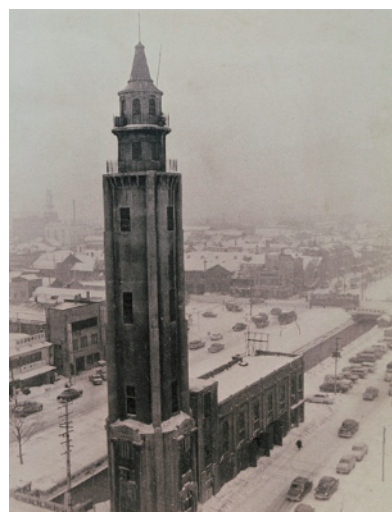
昭和2年に新築した消防本部庁舎
