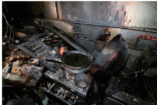
写真1-2 業務用ガスこんろの状況
