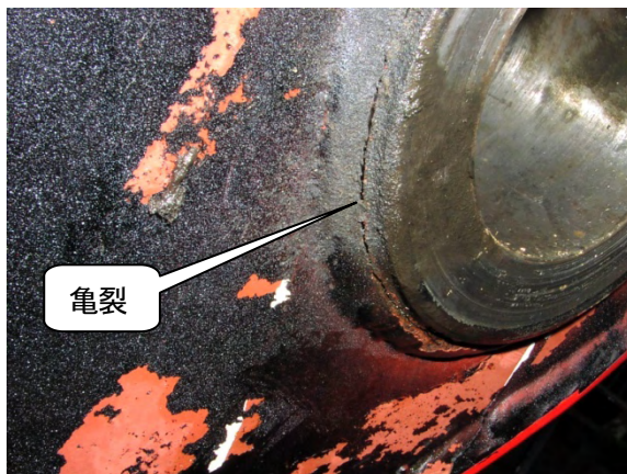
写真3 三角フレーム側
