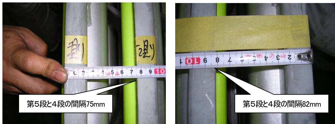
写真6 梯体昇降機用レール
