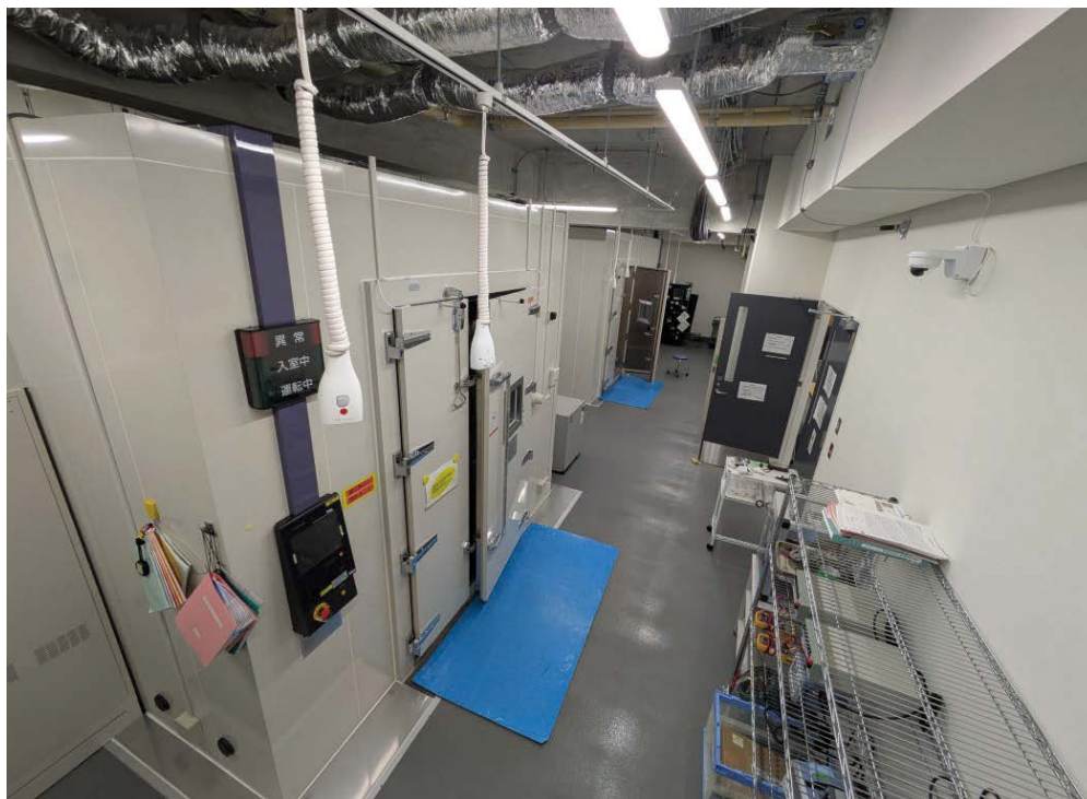
図1 周囲温度試験室全景（手前1号機、奥2号機）
