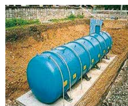
【耐震性貯水槽】
