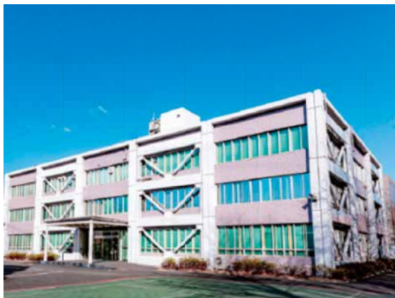
（旧中央試験場解体前）
