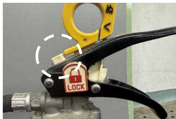
写真2-3-1④ 封の欠落
