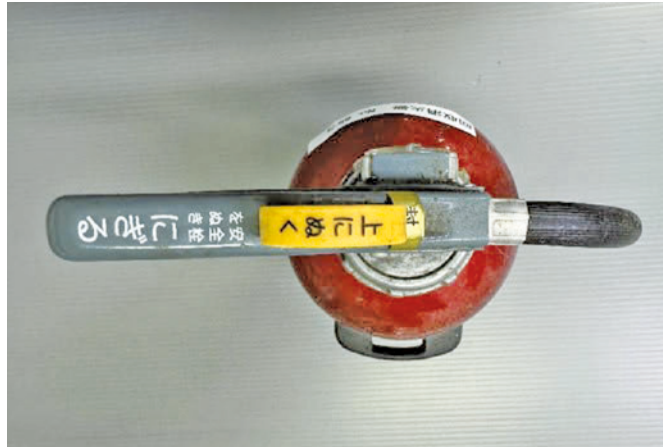
写真2-3-4① 正常な安全栓及びレバーの表示例
