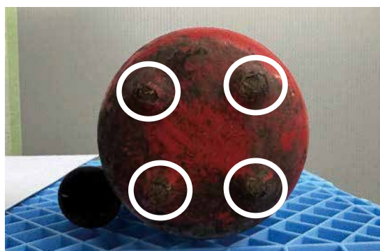
写真2-2② 底部の腐食
