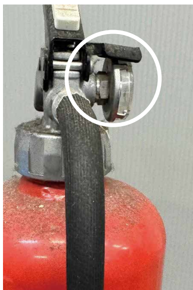
写真2-3-2① 正常な保護カバーと指示圧力計の例
